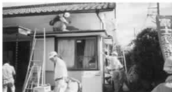
7月26日・27日 精神障害者共同作業所「ボブリ作業所」の建築
